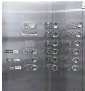
รูปที่ 3 รูปแสดงปุ่มกดขอความช่วยเหลือหรือแจ้งเหตุฉุกเฉินภายในลิฟต์
